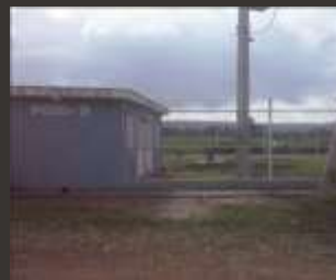
POZO N. 9 LA TUNA
