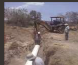
OBRA EN LA MESITA
